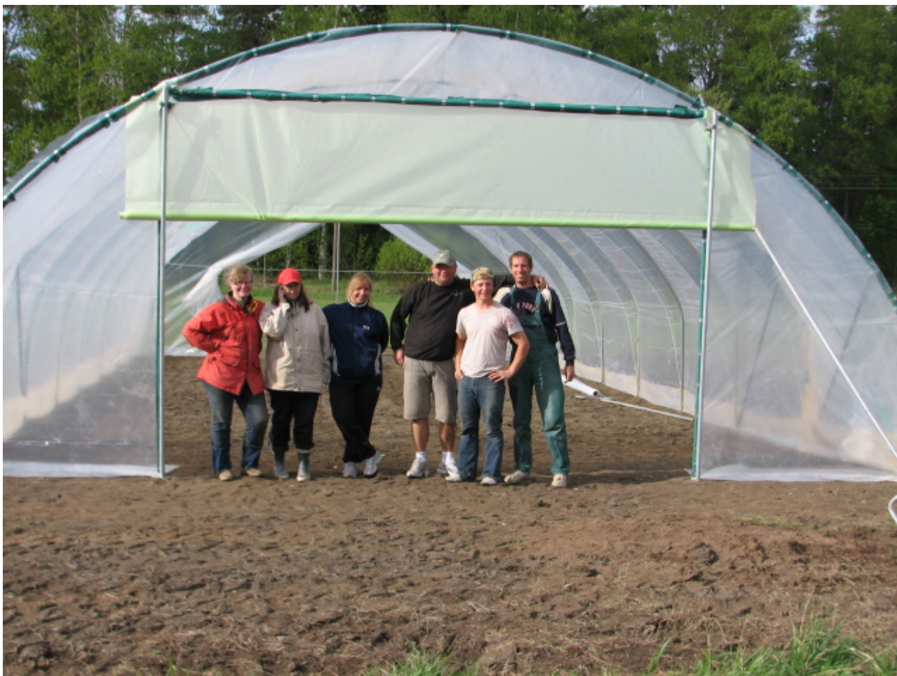
Kuvateksti: Kasvutunnelin pystytystiimi Jokioisilla
